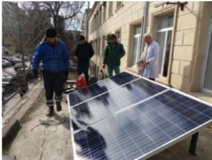
Şəkil 4. 750 Vt çıxış gücünə malik GFCM-nin Az ETN Radiasiya Problemləri İnstitutunun girişindəki fasadın üzərində yığılma prosesi
