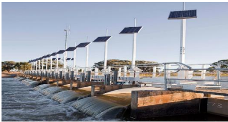
Şəkil 2. Günəş enerjisi hesabına kanal qapılarının idarə olunması(SCADA tətbiqi)
