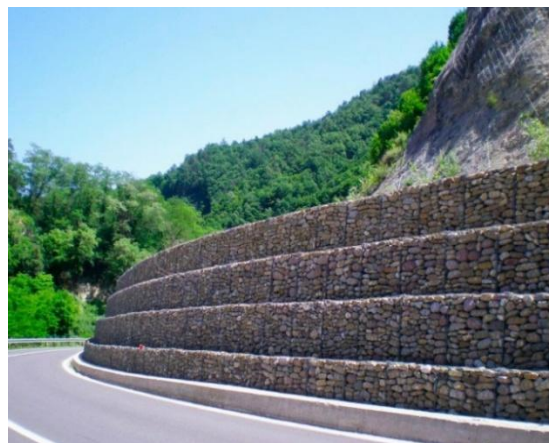
Şəkil. 1. Qabionla inşa olunmuş avtomobil yolunun görünüşü.
